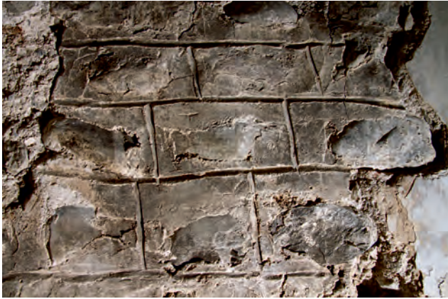
Der Fugenstrich-Verputz imitiert ein Mauerwerk. Diese Art des Verputzes wurde vom 8. bis zum 14. Jahrhundert verwendet.
