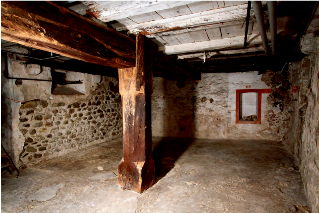
Keller von 1316. Original erhalten sind u.a. der Stud (Stütze) mit Balken und der Mörtelboden. Im Hintergrund der Notausstieg ins Nachbarhaus aus dem Zweiten Weltkrieg. (Roman Szostek)
